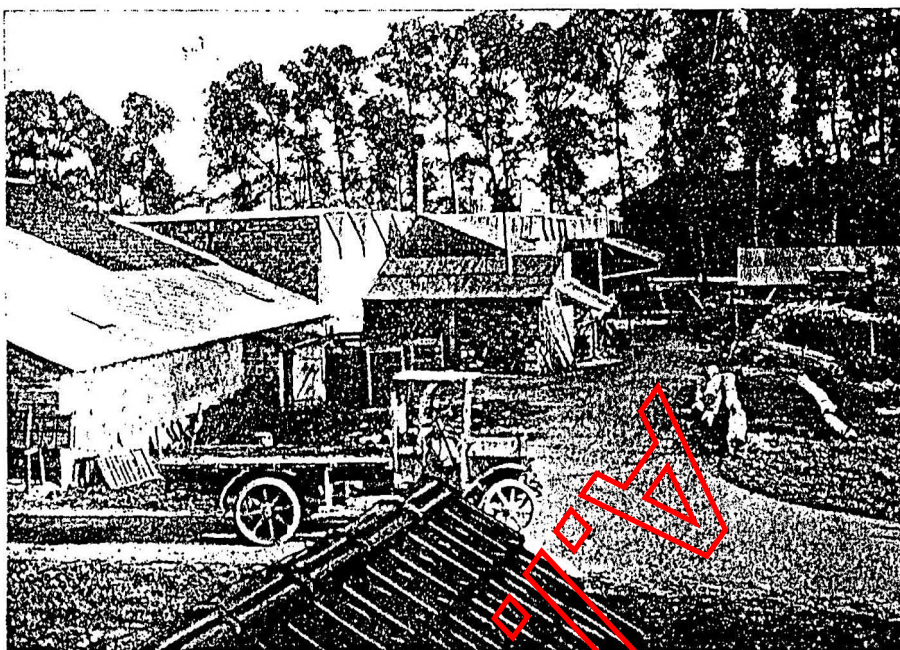
Vue extérieure de l'Usine. Entrée côté Scierie.
